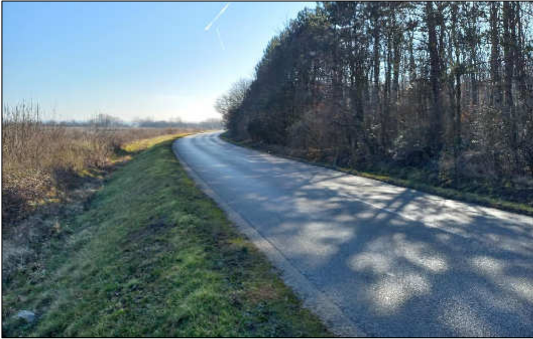
3.kép: Rálátás a 8. módosítás (071 hrsz) területére a 7213 sz. úttól ÉNy-i telekhatártól a szennyvíztisztító behajtó út kereszteződése felől
